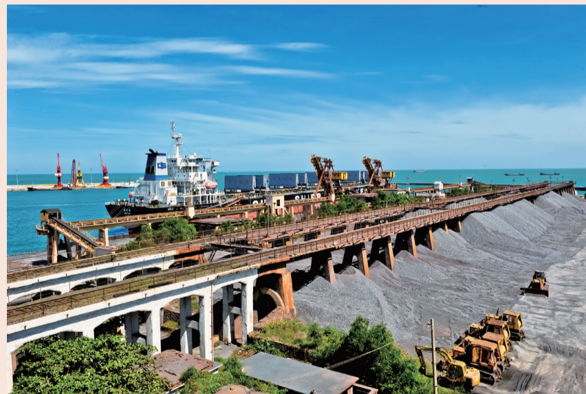
海矿石碌分公司八所港矿石码头
